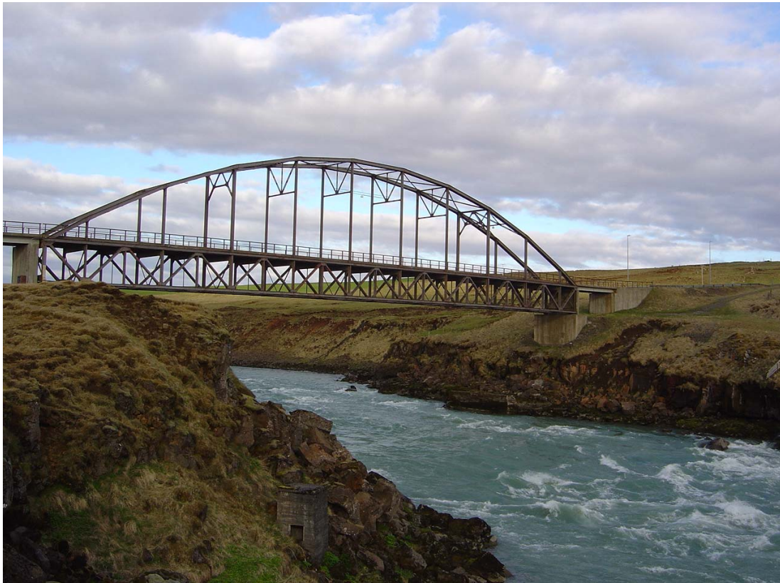
Einbreið Þjórsárbrú frá 1895 (önnur stórbrúin á Íslandi á eftir Ölfusárbrú 1891), endurbyggð 1949. Merkgilegur hlekkur í samgöngusögu Íslands. Hefur nú verið „vikið til hliðar“ fyrir nýrri tvöfaldri brú í samræmi við kröfur tímans. Fræðslu fyrir ferðamenn og jafnvel aðra aðstöðu vantar við brúna.
